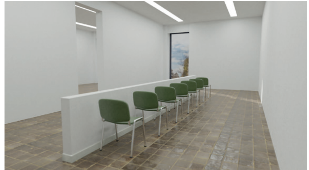
Eingebaute Wand mit Sockelleiste, weiss gestrichen (Dispersion), dahinter eine Reihe Stühle
