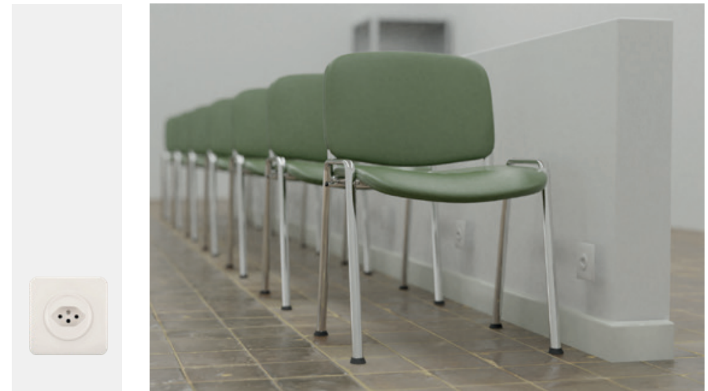
Eingebaute Steckdosen (in der im Raum stehenden Wand)
